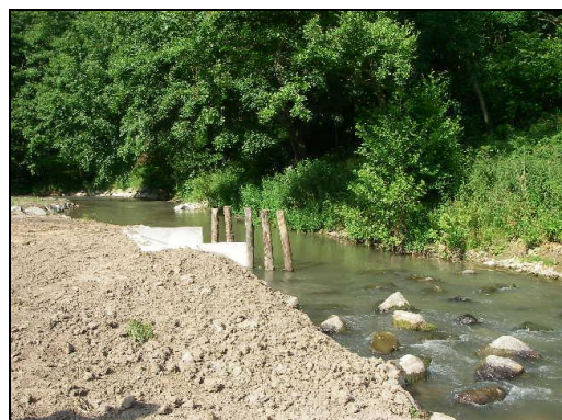
Prise d'eau installée en 2013
