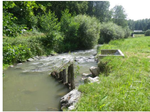
Prise d'eau installée en 2014
